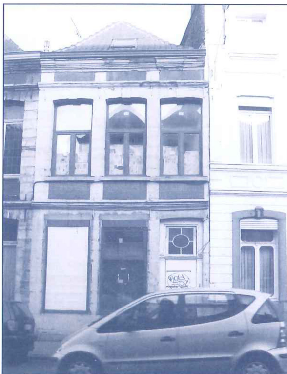
17, rue de la Madeleine. Avant rénovation.
